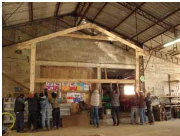
Un portique pour une maison de 100m2 et monté en quelques heures avec Etienne et un charpentier.
